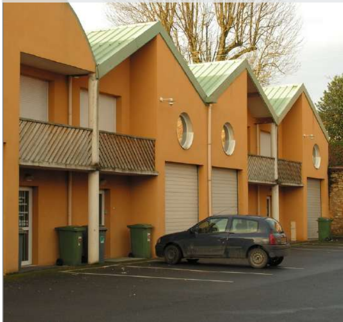
Cellules artisanales, rue du Maréchal Leclerc
