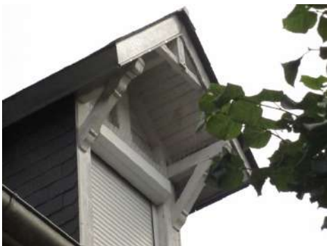
Exemples de toiture avec éléments de charpente apparente → à préserver
