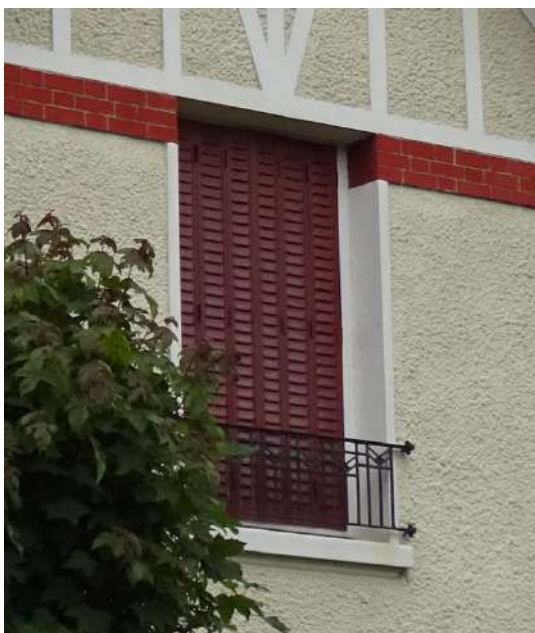
Exemple de volets en fer traditionnels repliables en tableau → à préserver
