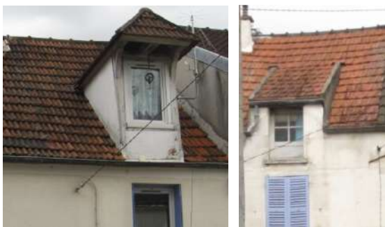
Exemples de lucarnes de grenier de maisons rurales → à préserver
