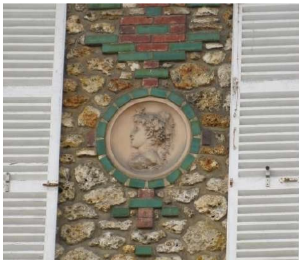
Exemple de médaillon en façade d'une maison traditionnelle, accompagnant l'ouverture, et de décors en brique → à préserver
