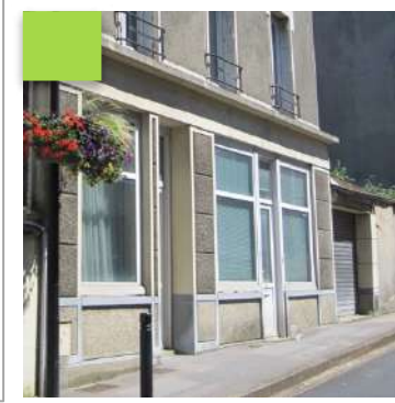
A favoriser : exemple d'une organisation de façade commerciale « moderne » intégrée à la composition de la façade de la construction ancienne
