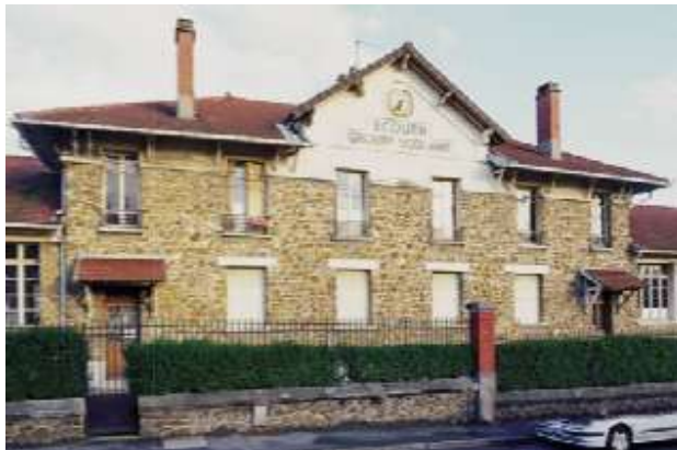
12 avenue du Maréchal Foch Groupe scolaire
