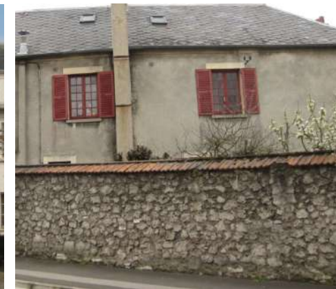
Exemple de mur rustique en moellons apparents → à préserver
