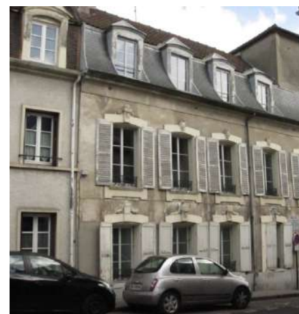
Exemple de toiture avec combles brisés couverte en ardoises et tuiles → à préserver
