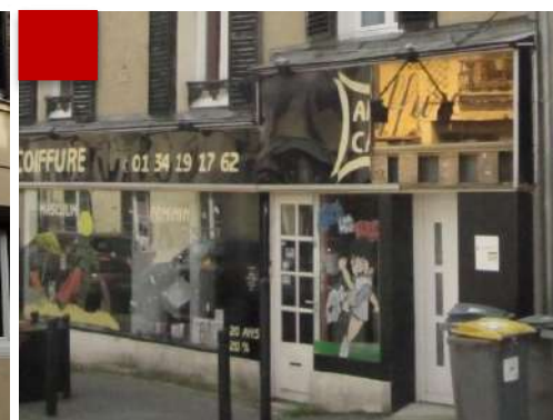
A éviter : exemple de devantures commerciales peu adaptées à une construction ancienne
