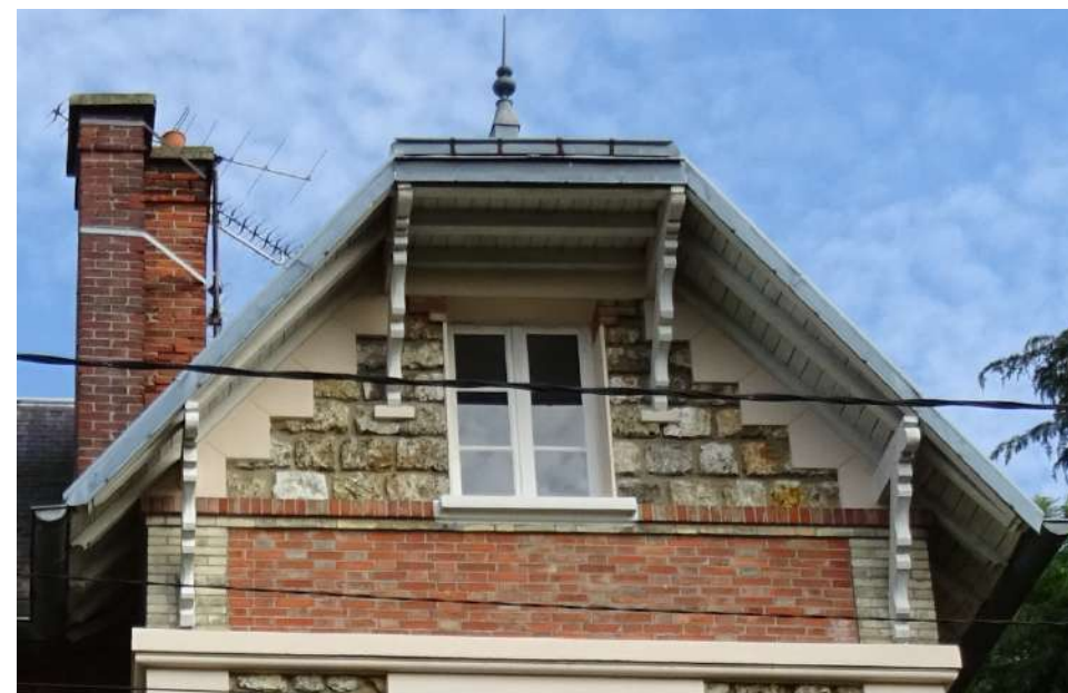
Exemple de toiture avec éléments de charpente apparente et épis de faîtage → à préserver
