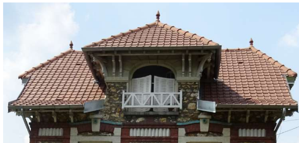
Exemple de toiture avec éléments de charpente apparente et épis de faîtage → à préserver
