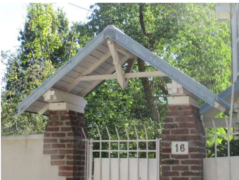
Exemple de piliers d'encadrement de l'accès à la maison traditionnelle, surmontés d'un auvent → à préserver
