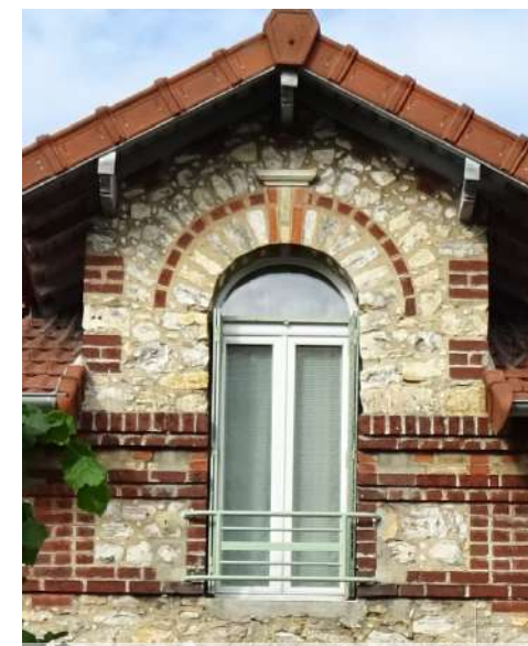
Exemple de décor en brique sur une maison traditionnelle en meulière : accompagnement de la forme de la baie, soulignement du niveau → à préserver
