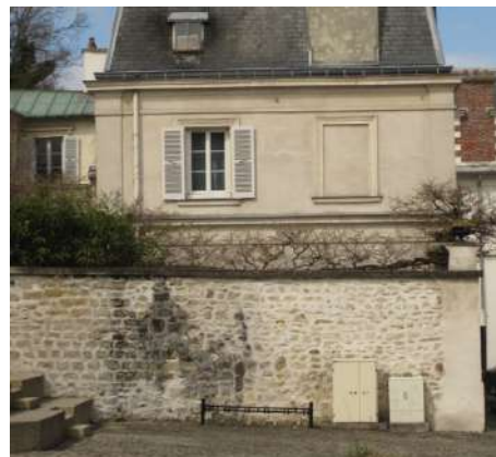
Exemple de mur en maçonnerie avec enduit à pierres vues → à préserver
