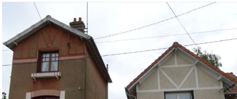
Exemples de faux-colombage en enduit ciment en partie haute de la façade → à préserver
