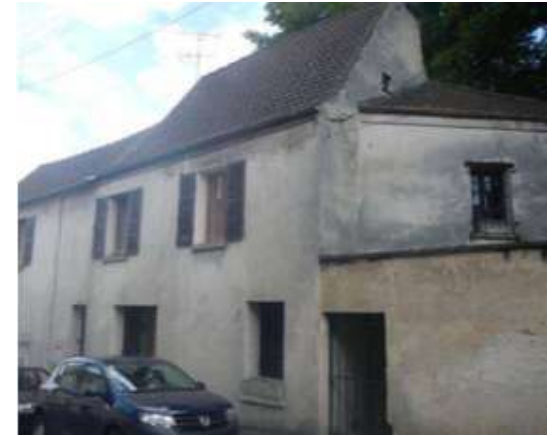
8 rue de la Grande Fontaine Maison ancienne
