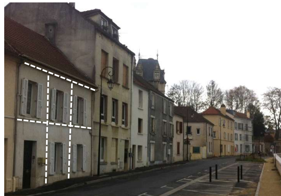
Illustration des caractéristiques des ouvertures des maisons de bourg : baies plus hautes que larges, alignements horizontal et vertical des ouvertures → à préserver
