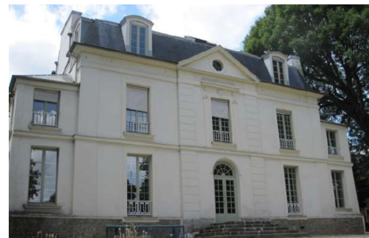
Illustration des caractéristiques des ouvertures des maisons de notable et des demeures bourgeoise : façade composée autour d'un axe symétrique, baies plus hautes que larges, alignements horizontal et vertical des ouvertures → à préserver
