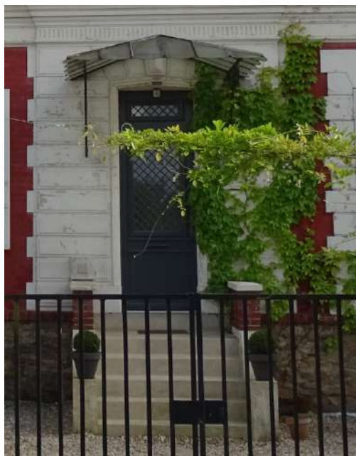
Exemple de seuil de porte en pierre avec escalier et présence d'une marquise → à préserver
