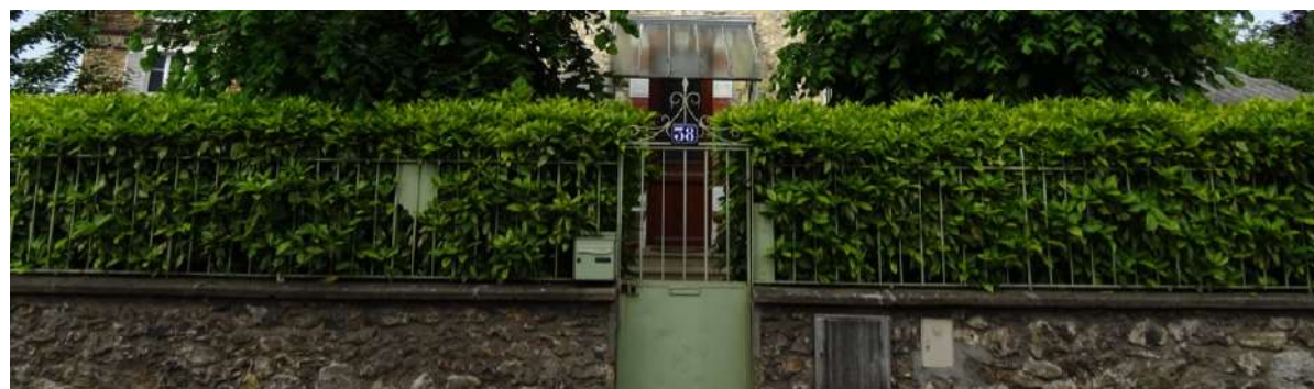
Exemple de clôture constituée d'un mur bahut en pierre, surmonté d'une grille doublée de végétation → à préserver
