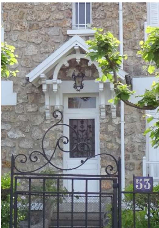
Exemple de porte d'entrée ancienne, avec impose vitrée et ferronnerie → à préserver
