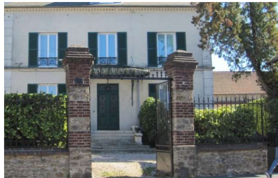
Exemple de mur bahut en moellons surmonté d'une grille, avec piliers en moellons et brique et portail en fer forgé → à préserver
