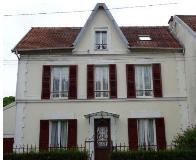
Exemple de façade aux percements à ordonnancement régulier → à préserver
