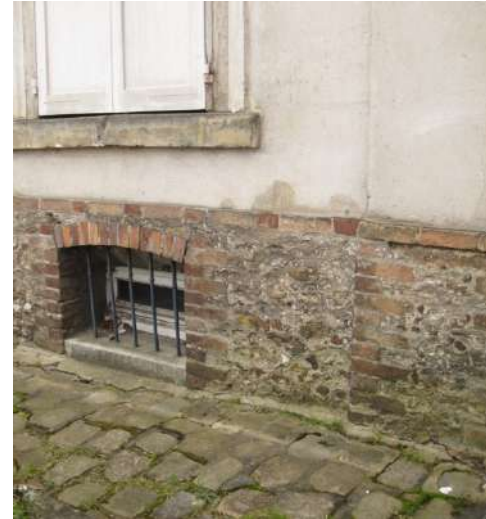
Exemple d'appui de fenêtre et de soubassement → à préserver
