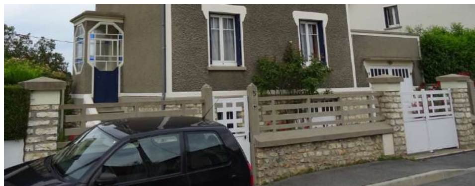
Illustration de la diversité des clôtures des maisons traditionnelles : mur bahut surmonté d'une grille en ciment, rappelant l'enduit de la construction → à préserver
