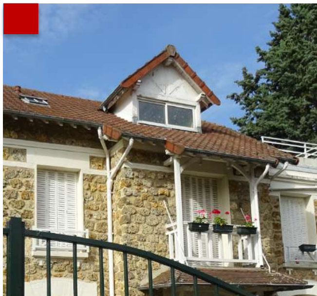
A éviter : lucarne qui ne respecte pas l'ordonnement et les proportions des baies existantes
